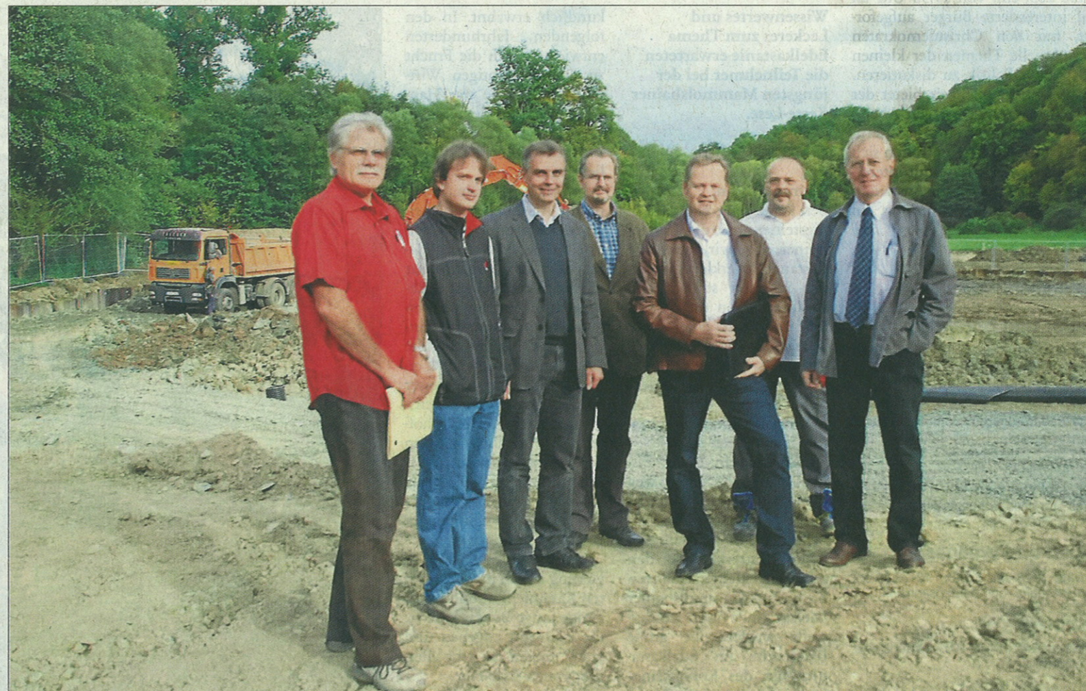
Hier wird ein neues Kombibecken gebaut: Rüdiger Putzke (v. l.), Andreas Stolz, Berthold Christmann-Neles, Wolfgang Messner (Geschäftsführer Abwasserverband), Axel Bangert, Daniel Cimander (Betriebsleiter Kläranlage) und Georg Goik beim Baustellenbesuch. Foto: rie
