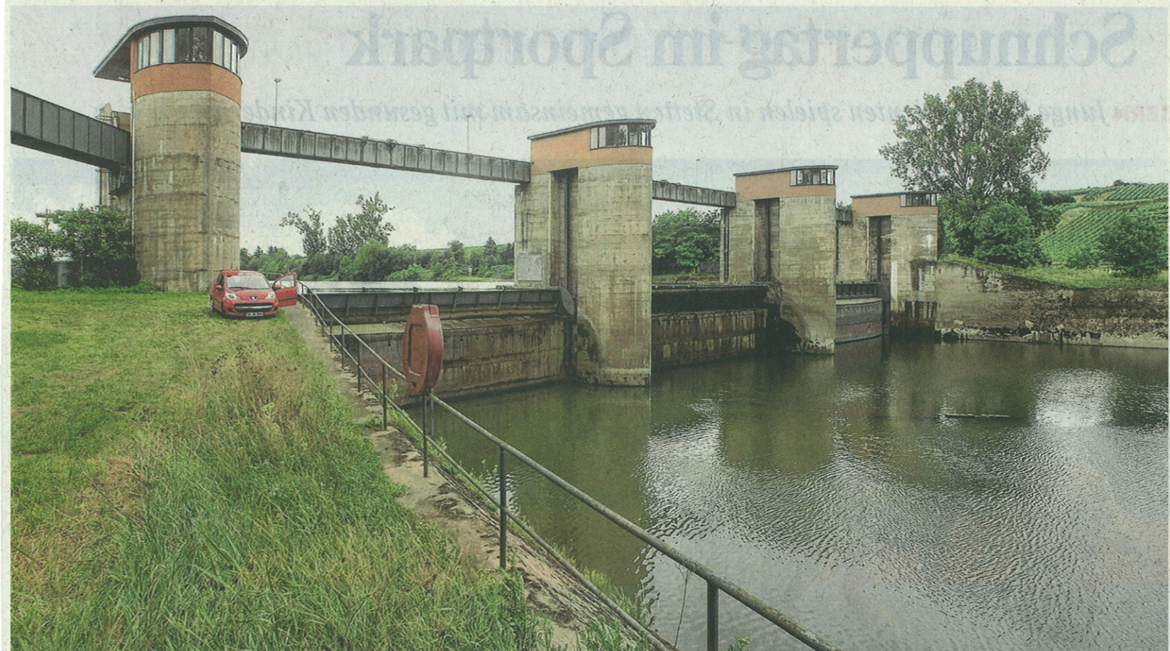
Sieben Jahre dauern die Bauarbeiten an dem mächtigen Wehr. Es schützt vor Hochwasser und macht den Neckar schiffbar.
